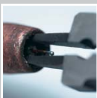
Удаление сварочных брызг изнутри и снаружи сопла.
